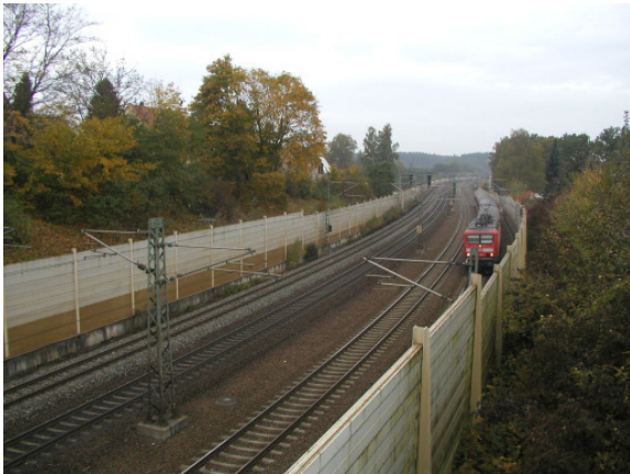
Standort Abenberger Straße; Blickrichtung Norden links ist die Böschung mit den etwas erhöht liegenden Wohnhäuser erkennbar
